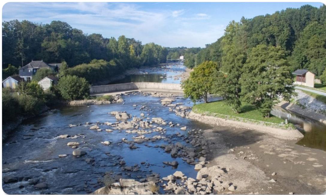
Chômage en septembre 2024 des biefs de la Mayenne, écluse de la Fourmondière supérieure (Montflours)
