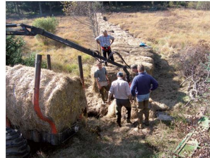
POSE D'UN BARRAGE EN BOTTES DE FOIN À L'AVANT D'UN ÉTANG POUR LIMITER LES DÉPARTS DE SÉDIMENTS LORS D'UNE VIDANGE
