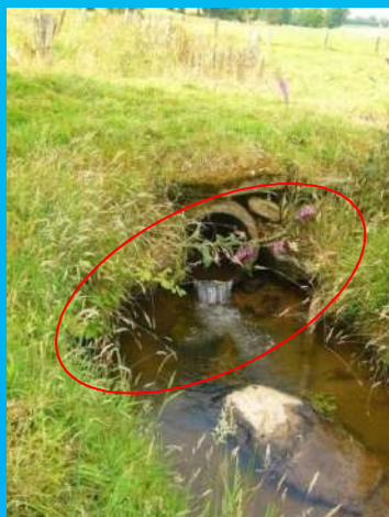
Buse mal calée et sous dimensionnée
