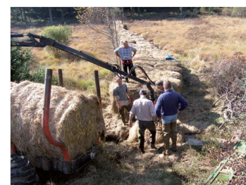
POSE D'UN BARRAGE EN BOTTES DE FOIN À L'AVAL D'UN ÉTANG POUR LIMITER LES DÉBITS DE SÉDIMENTS LORS D'UNE VIDANGE
