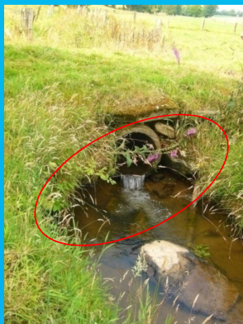
Buse mal calée et sous dimensionnée
