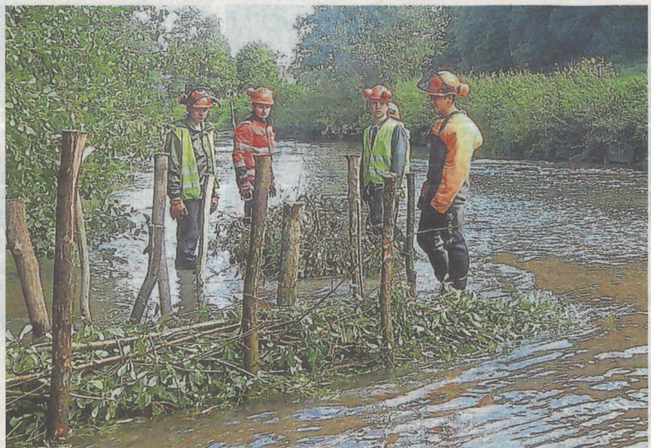
Les élèves de terminale GMNF du lycée Rochefeuille ont récolté des branches de saule pour créer cinq fascines installées dans le lit de la Colmont.
